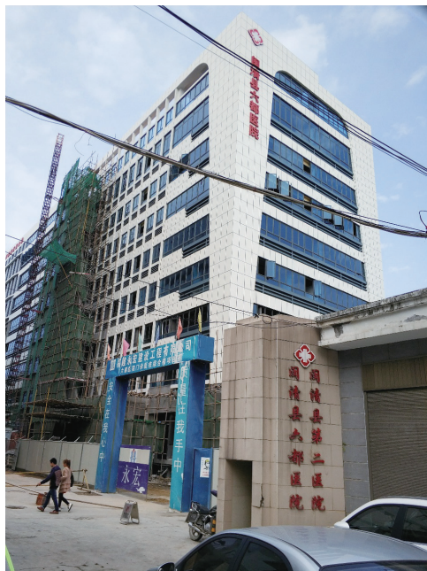
在修整中的闽清六都医院现状
