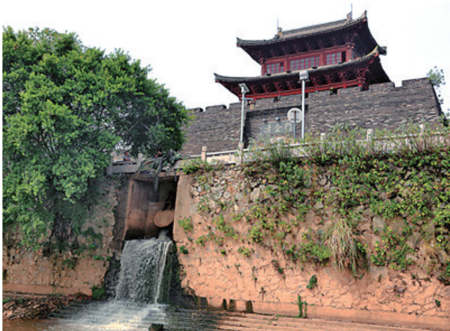
福寿沟排水口
