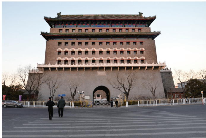
修复后的正阳门箭楼
