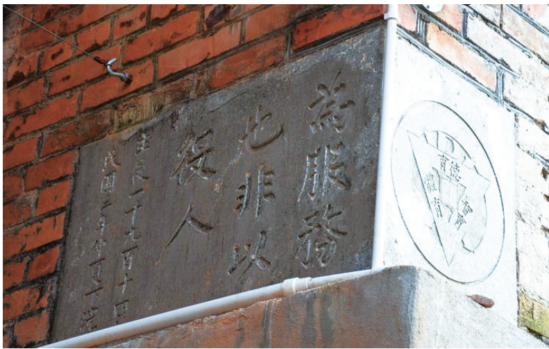
青年会一楼奠基时，基石石安装在墙角
