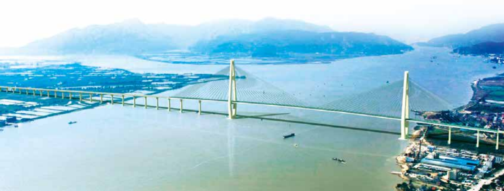
琅岐闽江大桥
