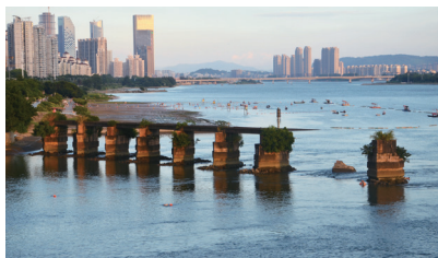
闽中断桥洪山桥
